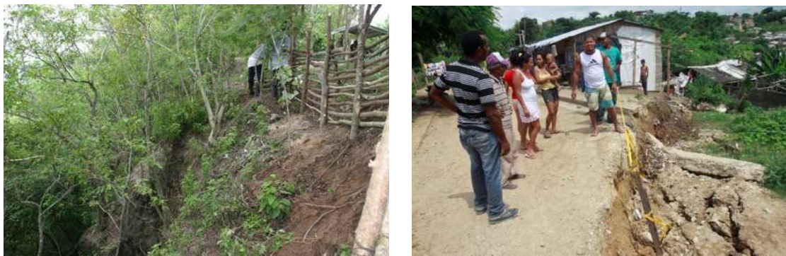
Figura 122. Carcavamiento de las laderas
