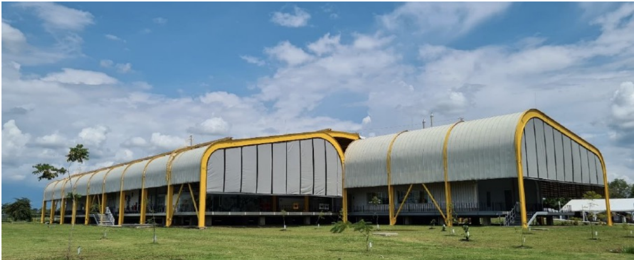
Foto 7. Vista general CIAT. Créditos Green Loop
